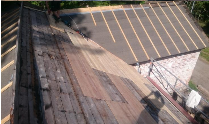
Uppe till vänster syns igenspikningen där skorstenen gått genom taket. När all skadad tro var bortbruten kompletterades med ny. Sedan lades papp, läkt och det gamla teglet på. Teglet kompletterades med gammalt av samma fabrikat (AWK) så långt som möjligt och sedan med annat med samma klacklängd.
