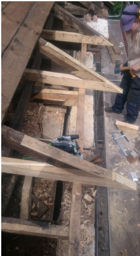
Alla takstolar fick olika lagningar beroende på vilka skador som fanns, för att bevara så mycket original som möjligt med bibehållen styrka. Här den gamla delen.
