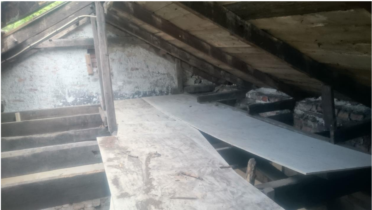
27 Gamla delens enda kompletta takstol är den mot muren.
