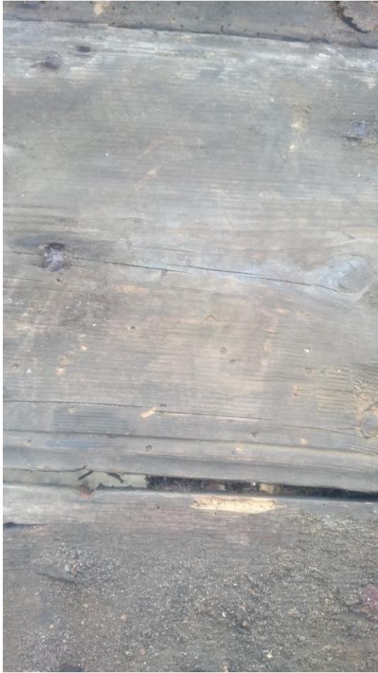
18 Fint hyvlad bräda med profil längs båda kanter.
