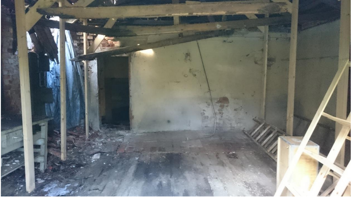
5 Tillbyggnaden med gamla delens yttervägg rakt fram. Det stora hålet till vänster. Notera hur bindbjälken högst upp i bild har ruttnat av i båda ändar och endast hänger i en bräda frånnocken.
