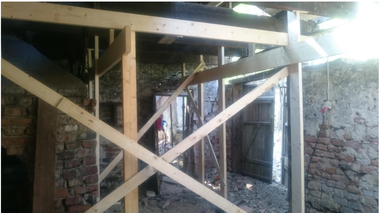
6 Uppstämning i gamla delen med möjlighet att lägga tillfälligt golv strax under bindbjälklaget.
