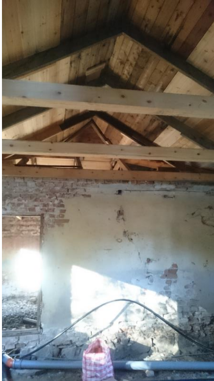
I nya delen skarvades sparrarna bara omlott med skruvförband.
