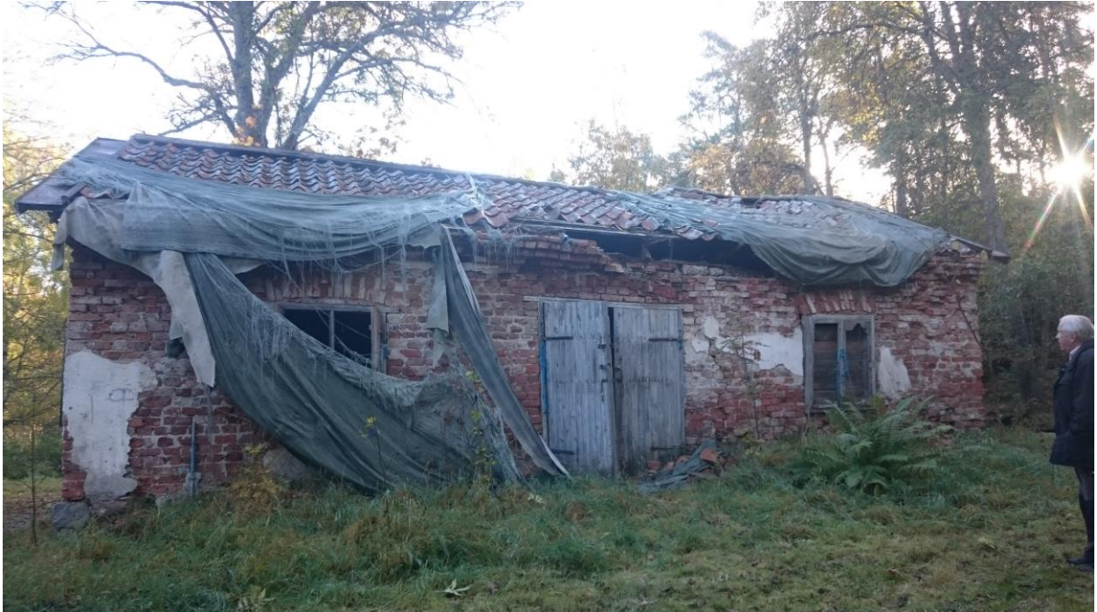
1 Den ursprungliga delen. Väggen har kalvat ut mellan porten och det högra fönstret. Sannolikt pga dålig grundläggning där.
