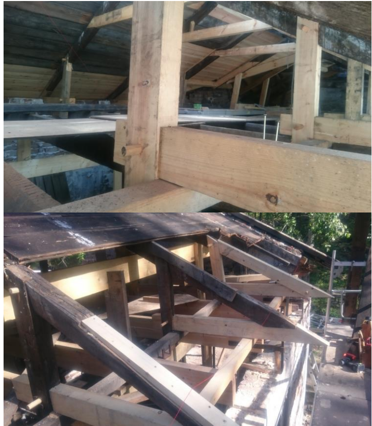
Alla takstolar fick olika lagningar beroende på vilka skador som fanns, för att bevara så mycket original som möjligt med bibehållen styrka. Här den gamla delen.
