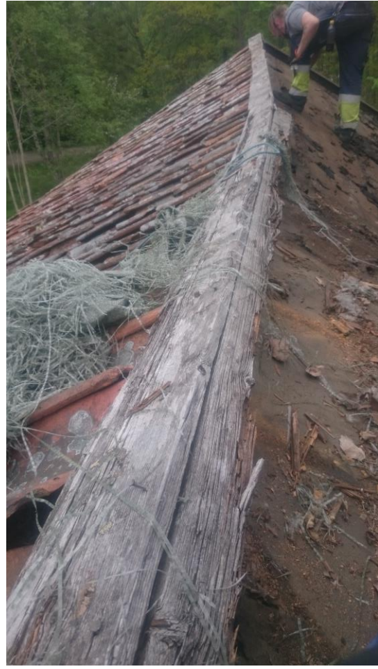
13 Kraftiga sättningar hade gjort allt skevt.
