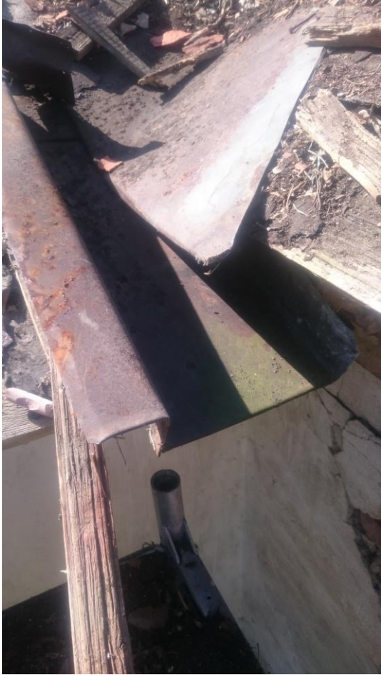
20 Avslutning på vinkelrännan mot nordost där skorstenen satt strax ovanför.
