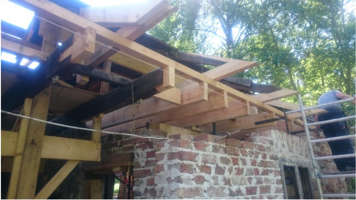
37 Lilla rummet fick helt nytt bindbjälklag.
