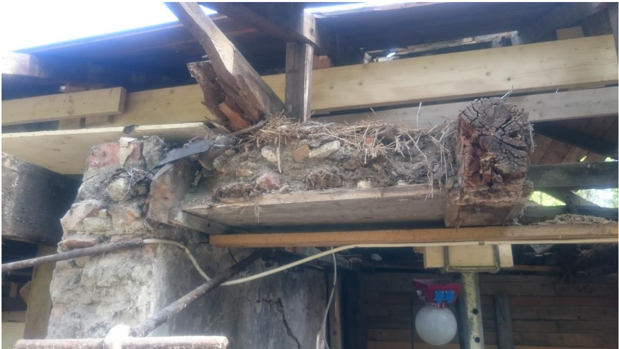
36 Lilla rummet hade isolering av jord, sten, sågspån, sot mm som gjort att fukten hållts kvar och alla bindbjälkar ruttnat.
