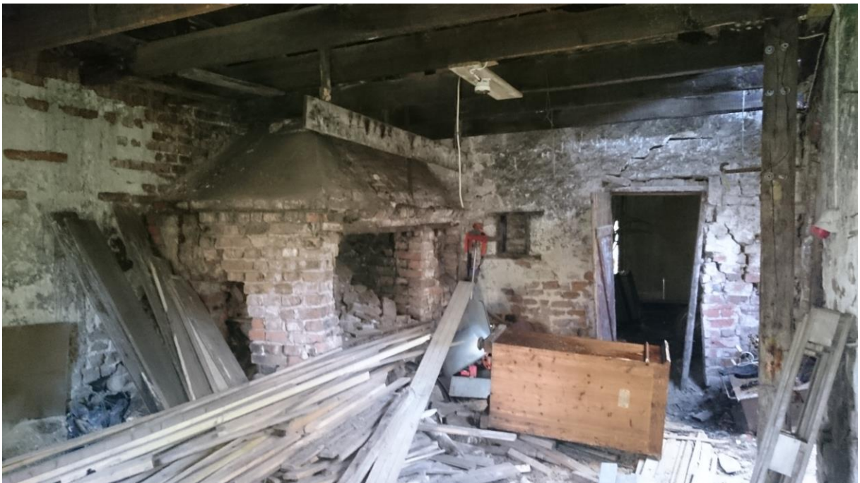
2 Innanför porten finns ässjan kvar men med riven skorsten som till stor del ligger som ett röse inuti.
