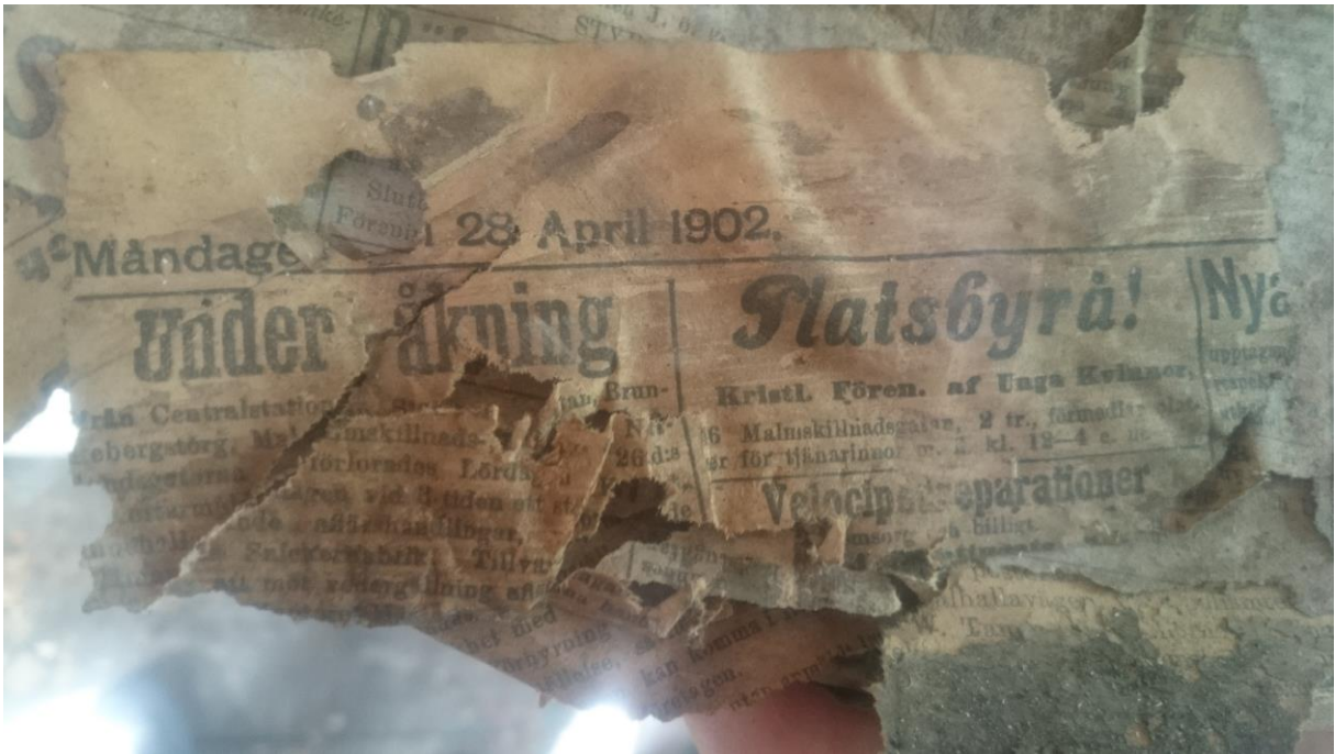
17 På den handhyvlade tron låg tidningar under pappen för att jämna ut ojämnheter. Vi tackar för den dateringen.
