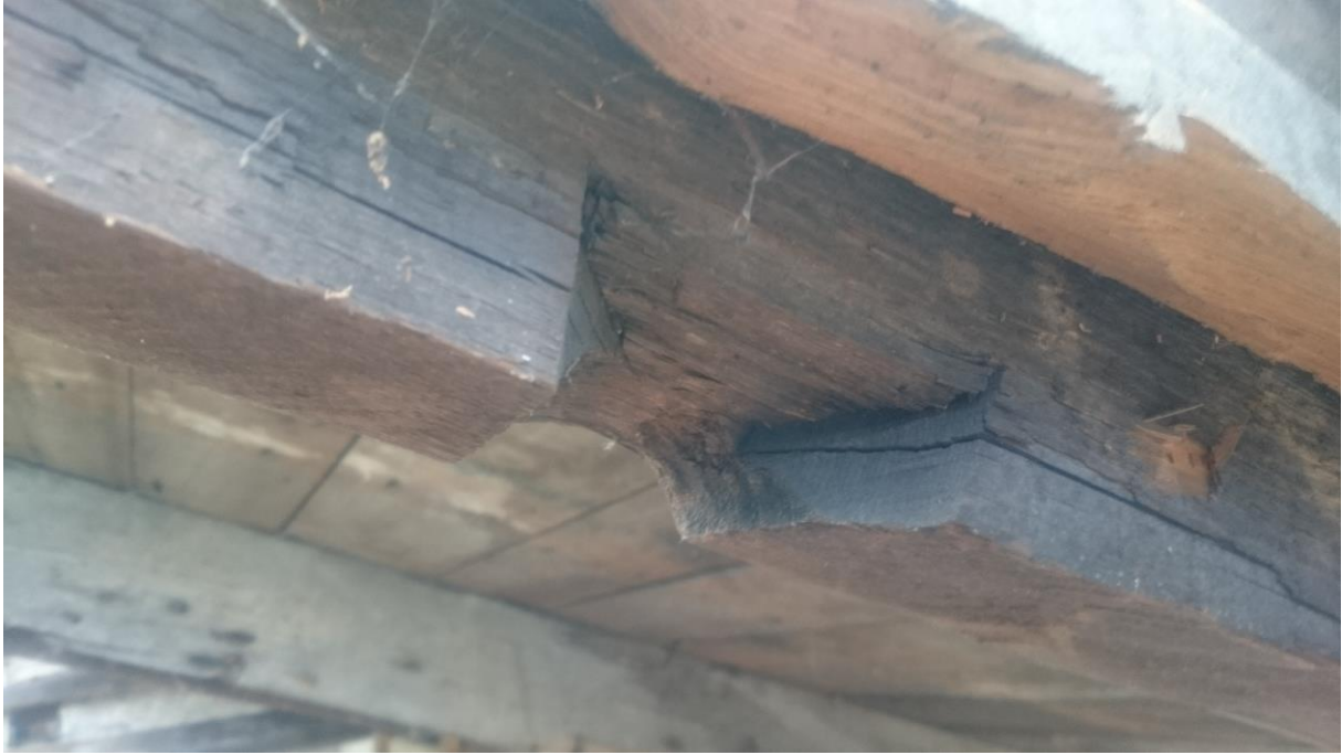
32 Många virken har omotiverade hål borrade igenom. Diameter cirka 50 mm. Ibland mitt i, ibland i kanten. Ibland i änden och ibland mitt på.
