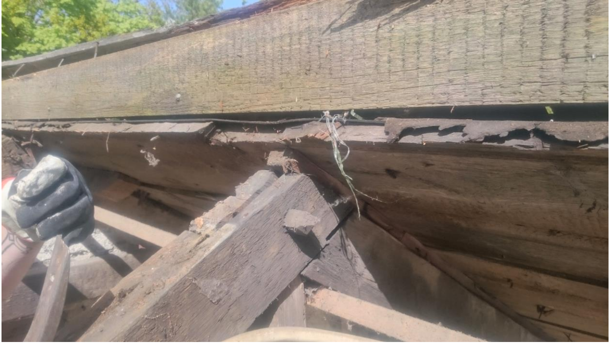
30 Bladning inock med dymling ca: 20 mm diameter.
