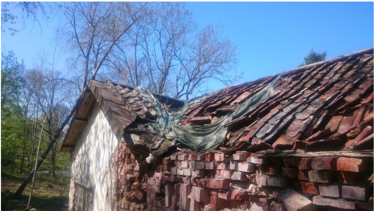
4 Nya delen till höger i bild ansluter mot gamla. Ett stort hål i taket där det mesta ruttnat och muren frostsprängts.
