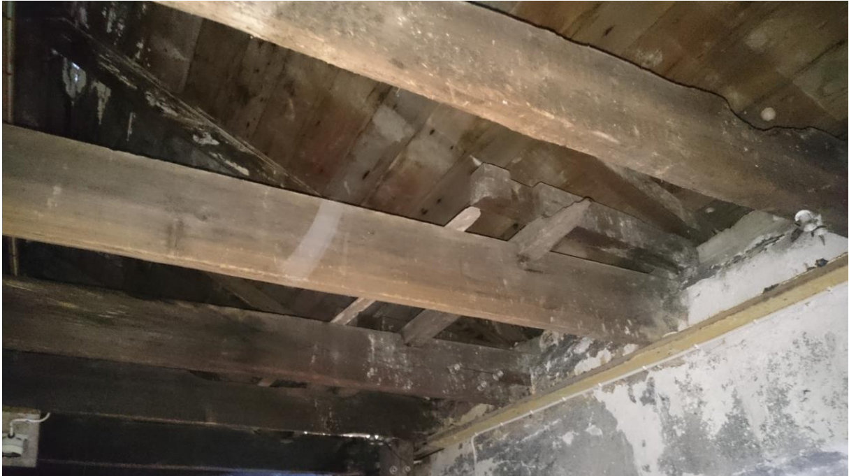
3 Remstycket avbrunnet och stödben saknas. Endast i gavlarna fanns hanbjälkarna kvar.
