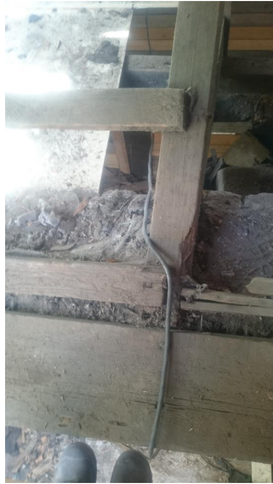
19 På den del av gamla taket som blivit inbyggd sitter ett par läkt som skulle kunna tolkas som att teglet från början legat på öppen läkt. Spikad med smidd spik som sitter kvar även längre upp. Då skulle denna del blivit inbyggd innan 1902 dock.
