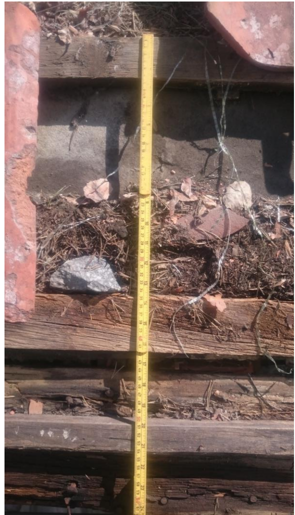
8 Läktavståndet varierade mellan 32 till 35 cm men de flesta låg på 34 cm. Mycket skräp hade hunnit samlas mot bärläkten som endast bitvis låg på tunna ströläkt.
