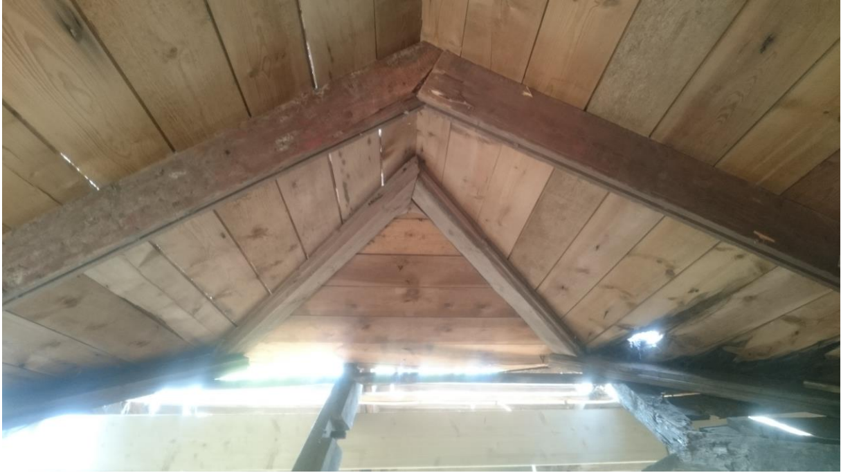
26 Tillbyggnadens anslutning till gamla delen.
