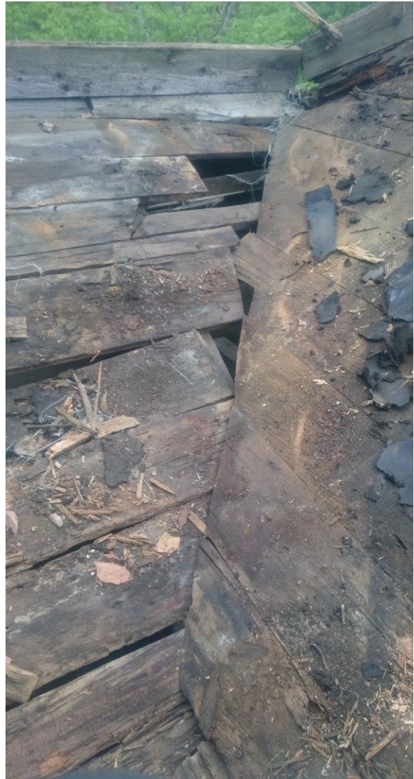
14 Det gamla taket till vänster ligger mestadels under det nya. Ett par av dessa bräder hade vattrännor. Se bild 15.
